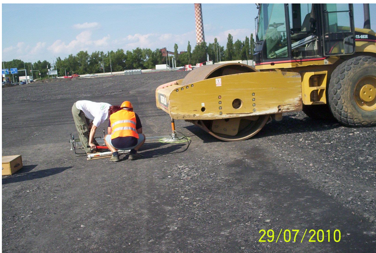
Zkouška na statiku po úpravě zeminy po dvou dnech E_{def2} \geq 90 \text{ MPa}
