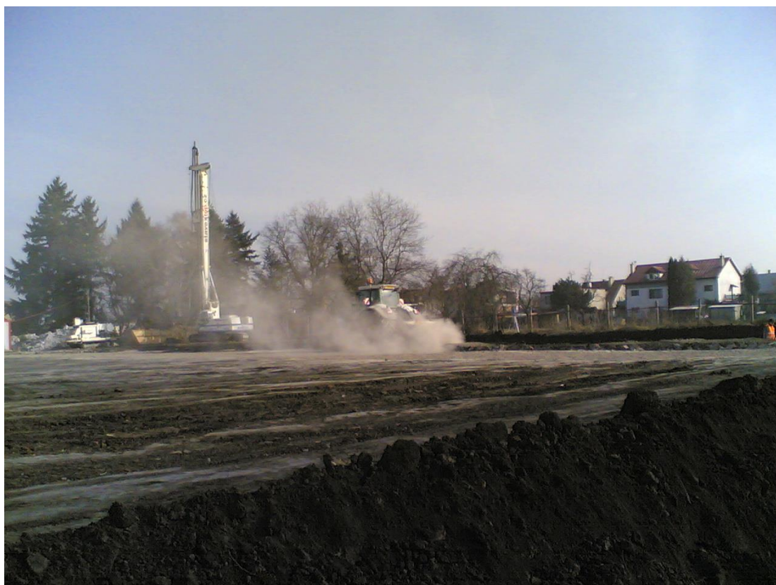
Práce frézy na stavbě TESCO Holešov
