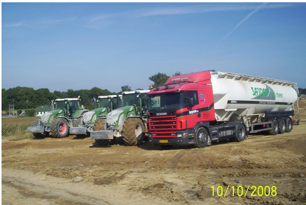
Ověřování pojiva RSS 5 na stavbě D47, autocisterna s pojivem a zemní frézy
