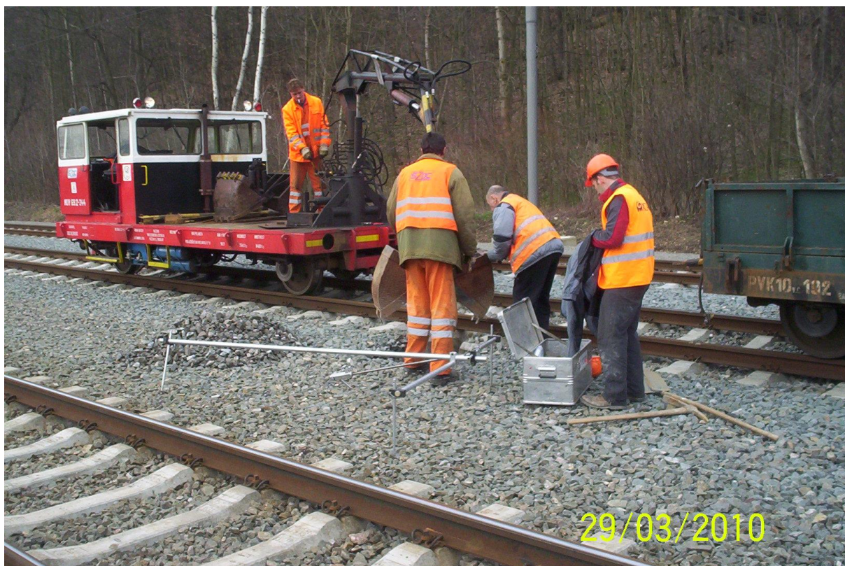
Měření modulu přetvárnosti Edef pomocí sondy po jednoročním provozování železniční koleje č. 3 – zkouška pojiva RSS 5 v Bludově
