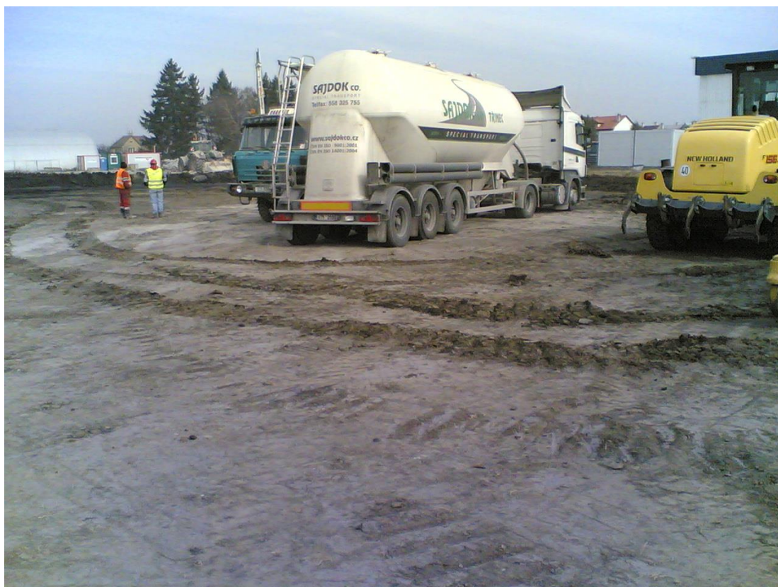
Autocisterna s pojivem RSS 5 při stavbě TESCO Holešov
