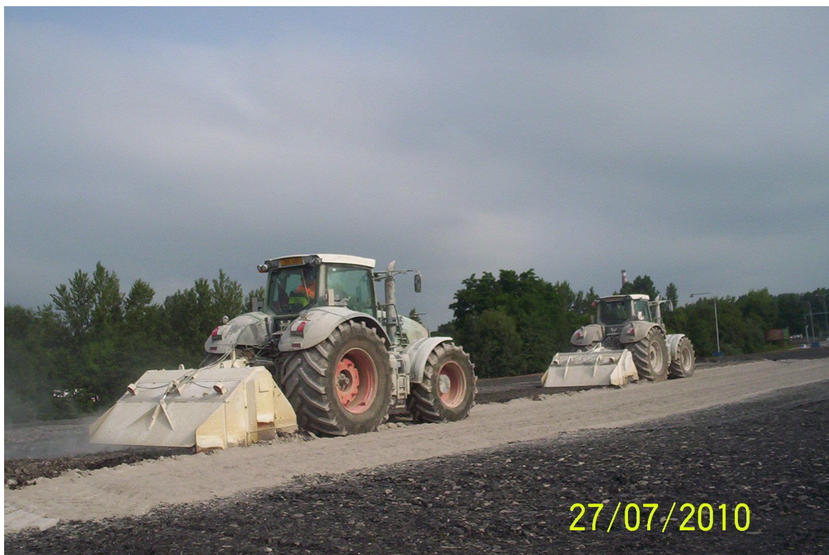
Míchání pojiva RSS 5 se zeminou a homogenizace směsi zemní frézou do hl. 0,4m
