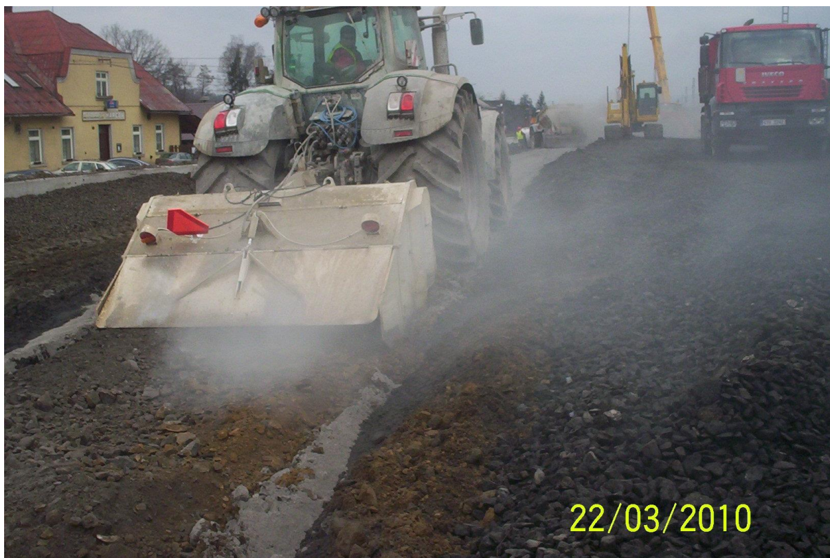
Práce frézy při aplikaci RSS 5 na stavbě rychlé komunikace v Hrádku
