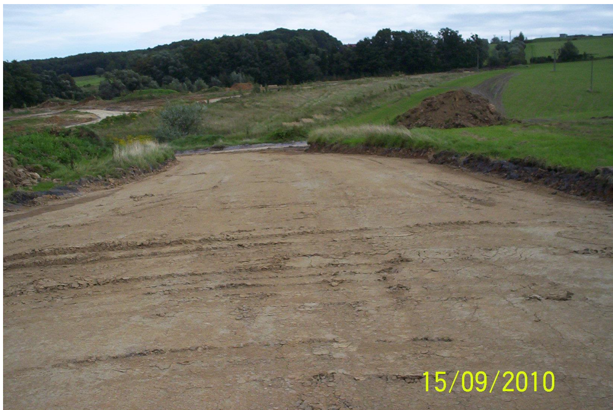
Pohled na areál po stabilizaci komunikací
