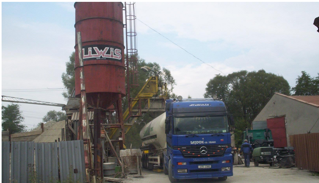
Míchací centrum LIWIS ve kterém bylo vyrobeno pojivo RSS 5 pro stavbu silnice v Jablunkově
