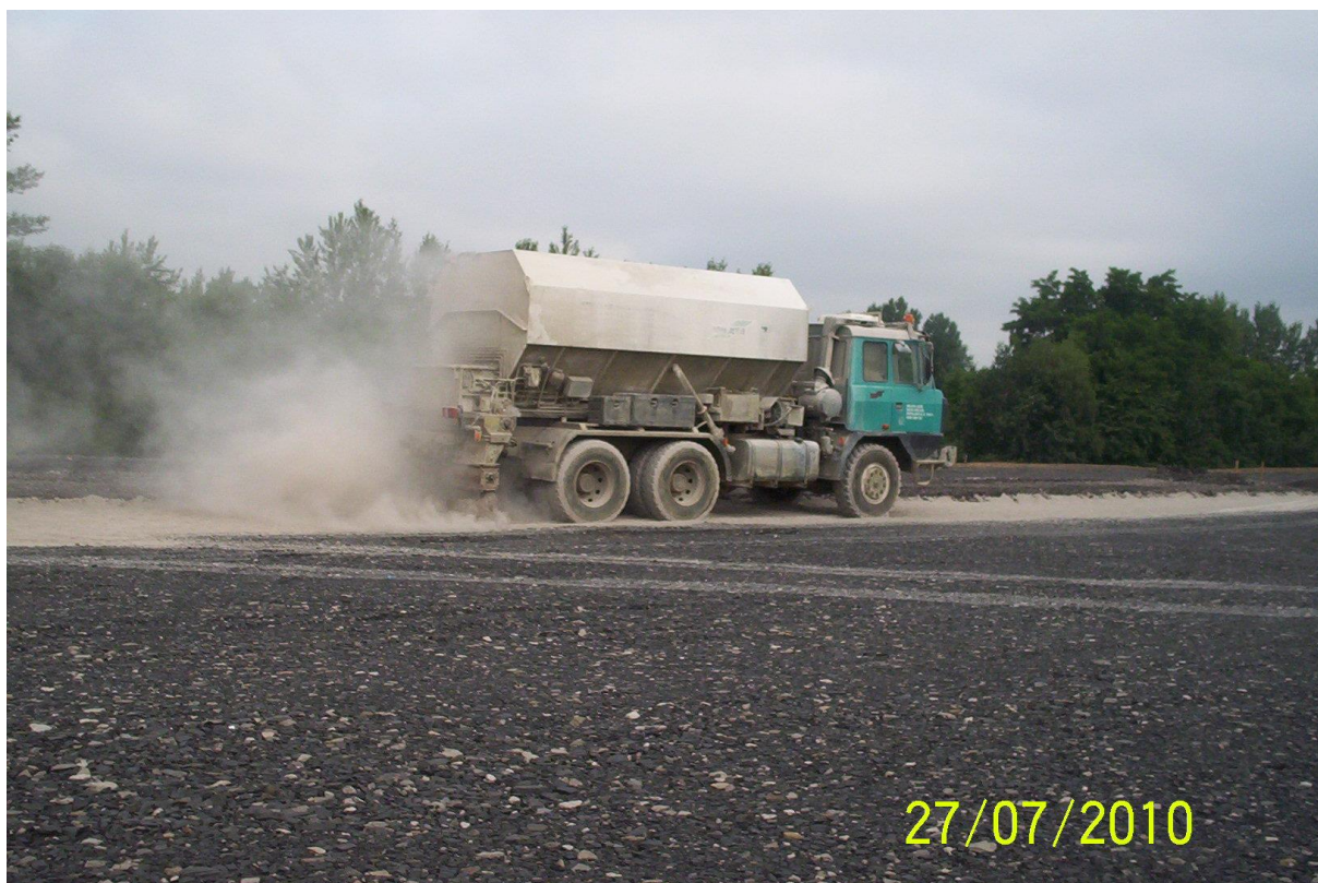
Aplikace hydraulického pojiva RSS 5 na zemní pláň
