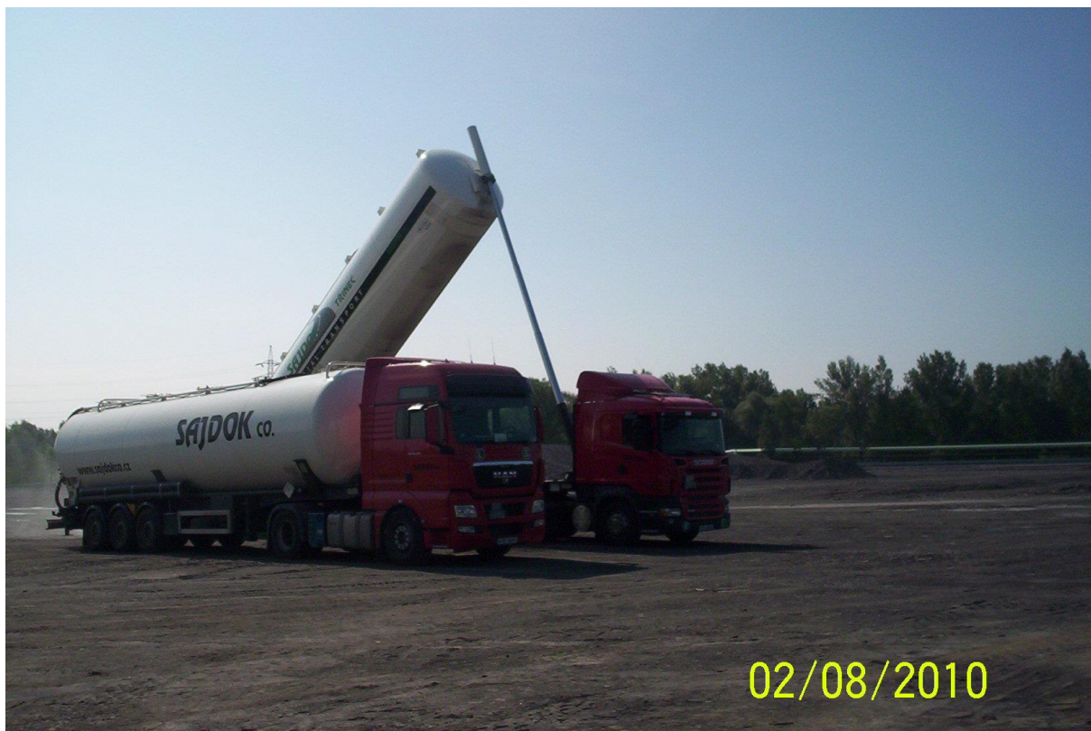
Dovoz hydraulického pojiva RSS 5 na stavbu
