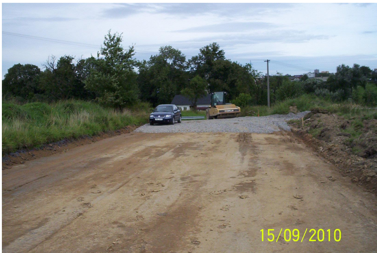
Část stabilizované komunikace – vjezd do areálu
