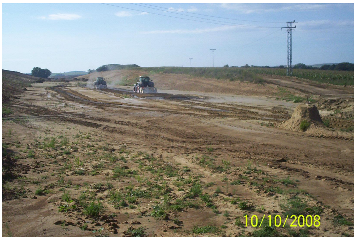
Zemní pláň D 47 ve Velkých Albrechticích a ověřování pojiva RSS 5, výroba vrstvy zeminy s pojivem
