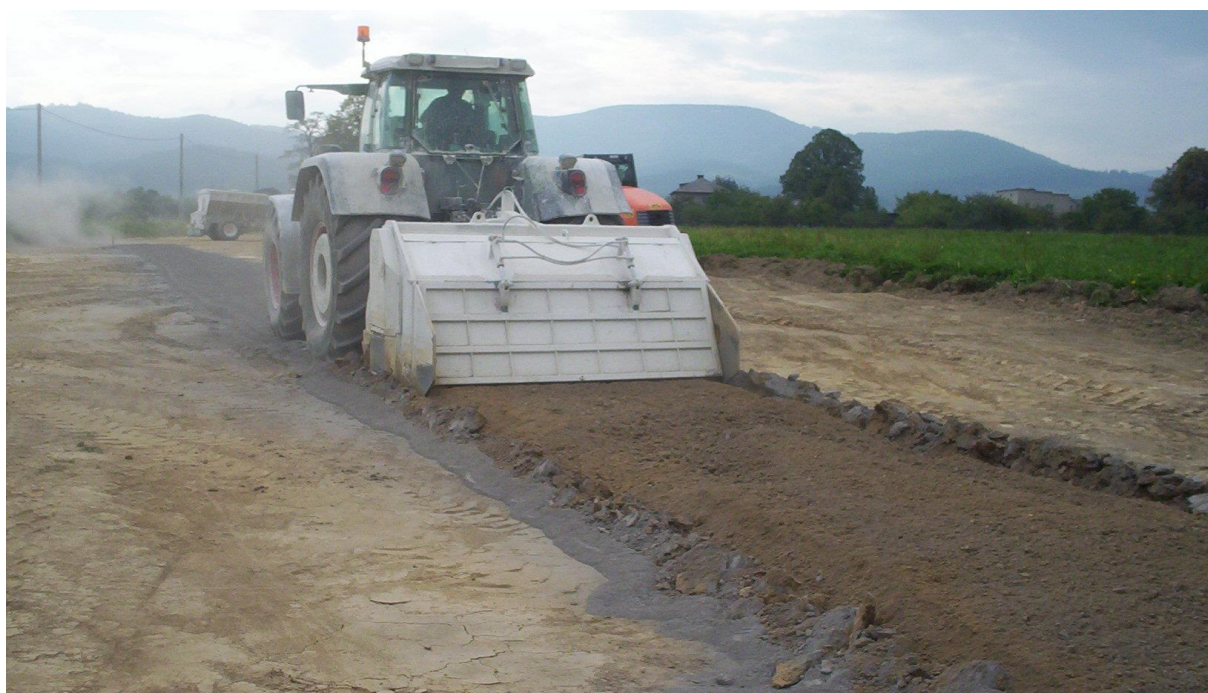
Zemní fréza provádějící míchání pojiva se zeminou a homogenizaci vrstvy při stavbě silnice v Jablunkově
