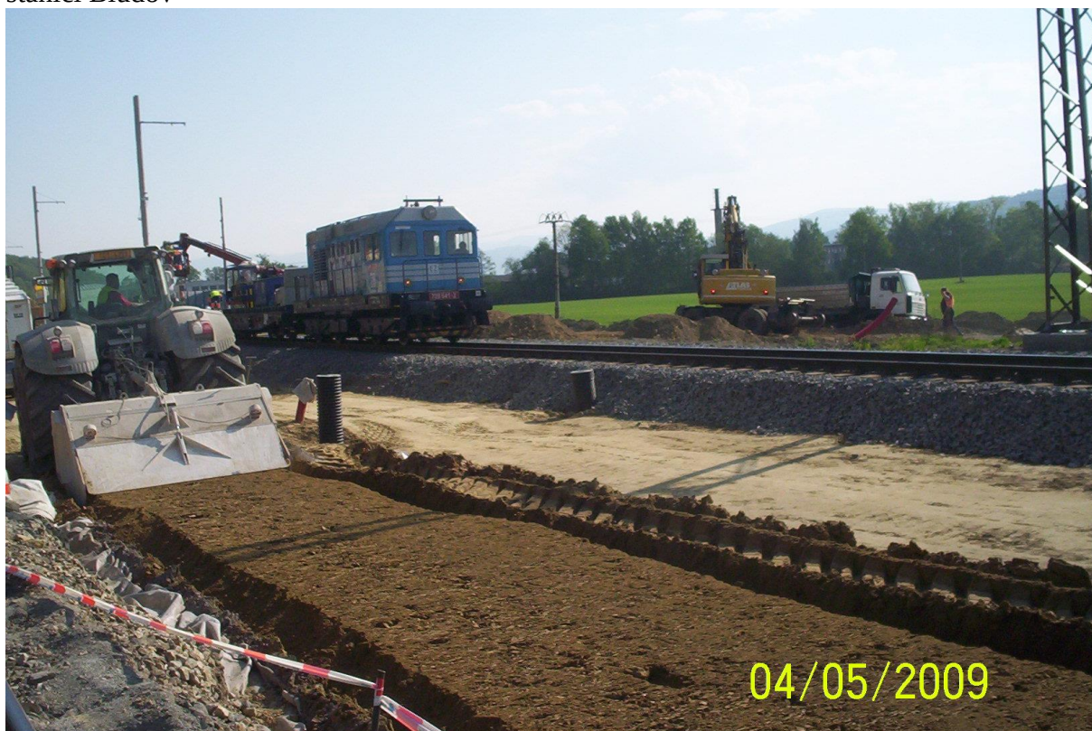
Práce frézy při zkoušce v žel. stanici Bludov
