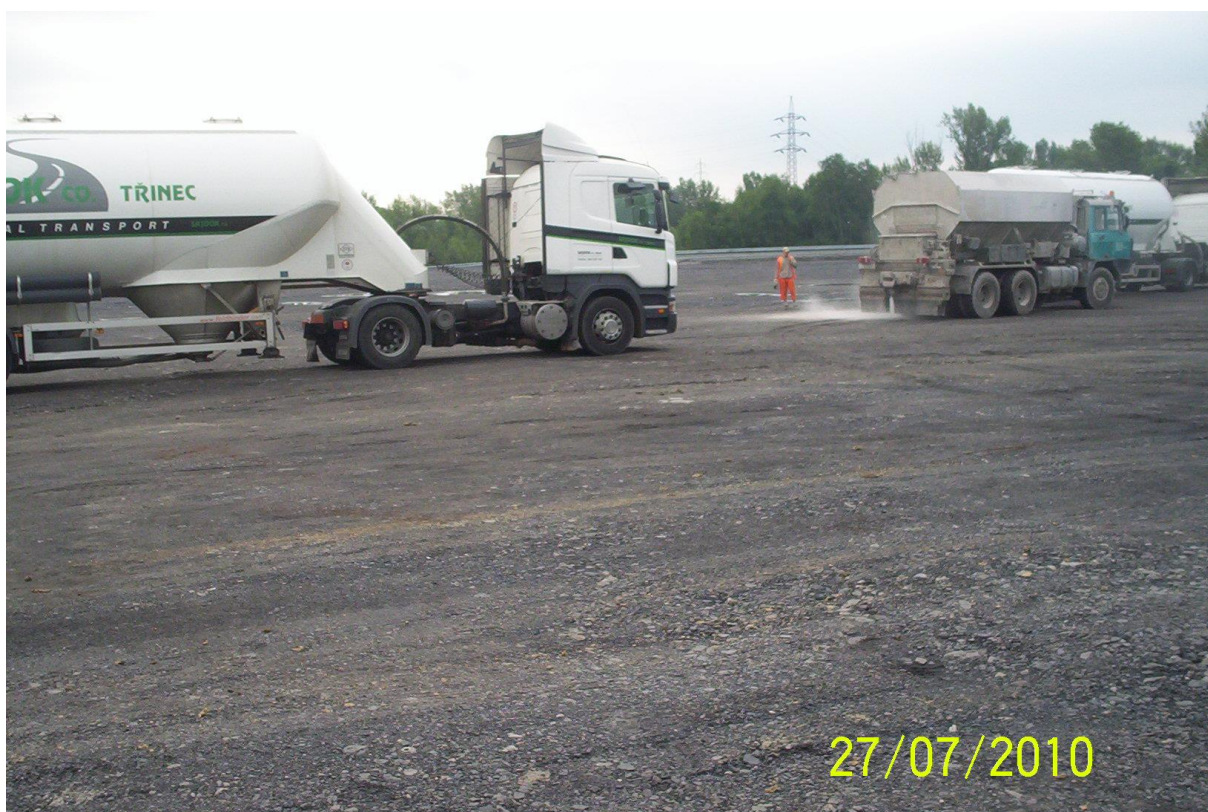
Odběr hydraulického pojiva RSS 5 z autocisterny do aplikátoru TATRA pneumatickou cestou
