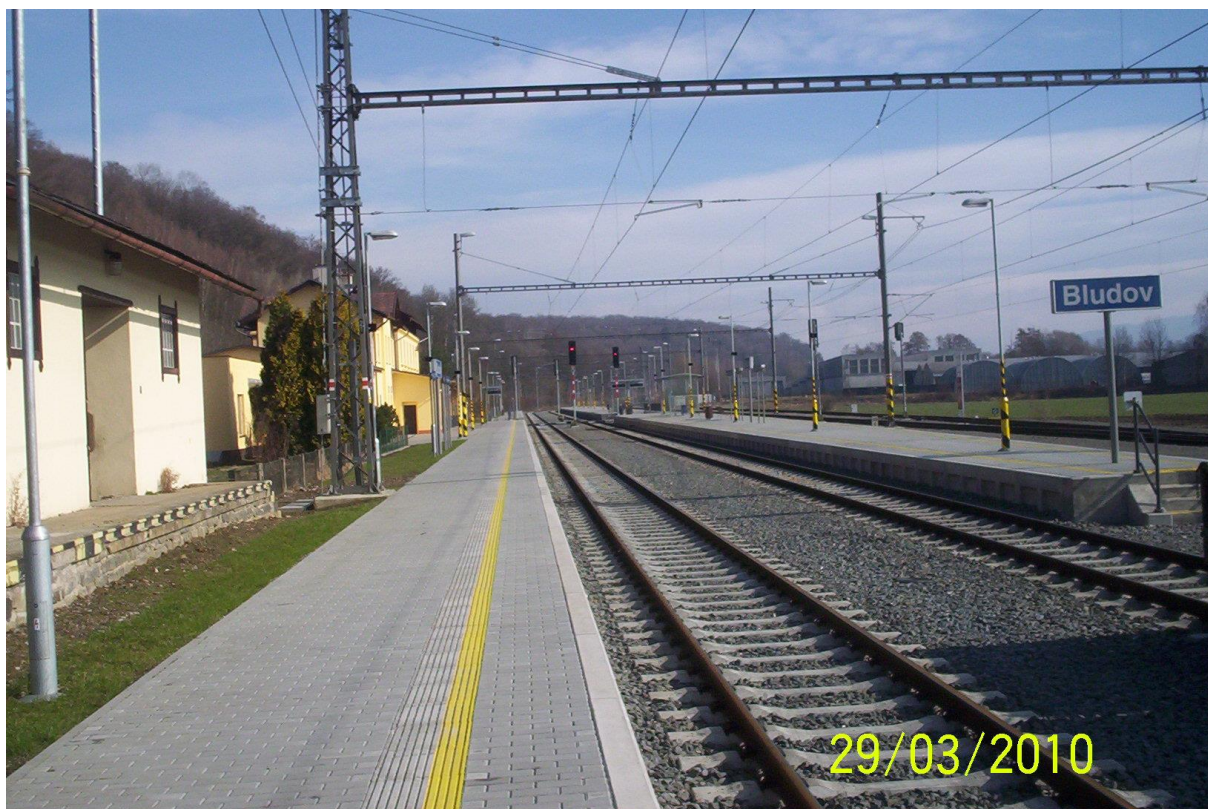
Nová kolej po aplikaci pojiva RSS 5 a zhotovení koleje č. 3 v Bludově
